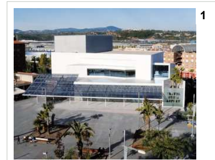
El teatre dedicat a Núria Espert té una pèrgola fotovoltaica. Foto: EL PUNT.
